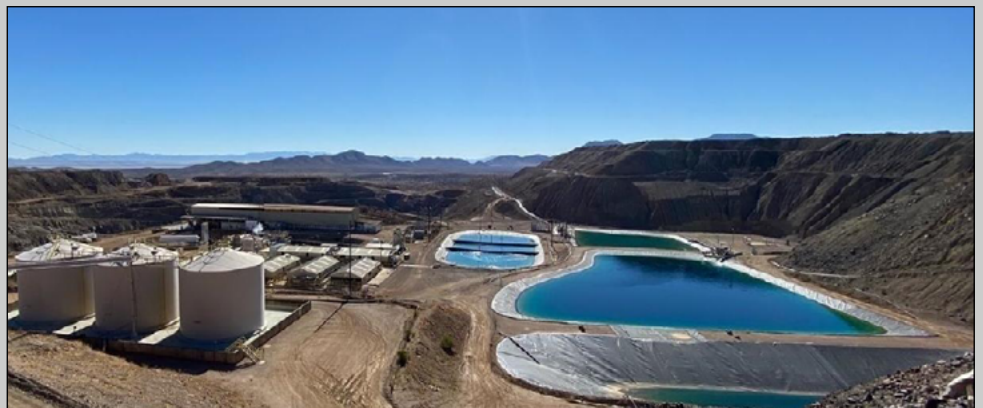
Abb. 3: Verarbeitungsanlagen der Johnson Camp Mine mit der Tagebaugrube Burro hinten links (Quelle: Gunnison Copper)
