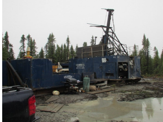
Bohrgerät bei der Arbeit : Eigenaufnahme
